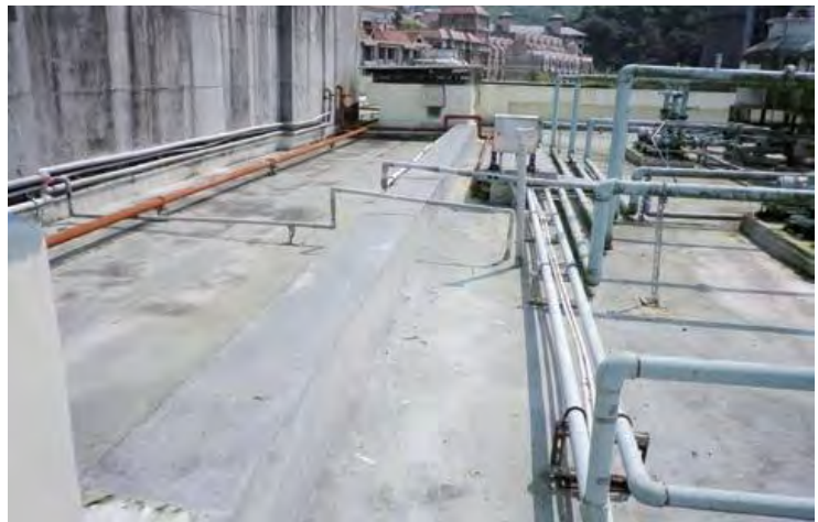
圖：屋頂滲水整修前(上)、整修後(下)
